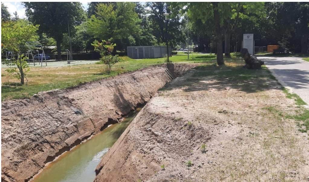
Afbeelding 5. Juli 2022 waren de graafwerkzaamheden op sectie 8 afgerond.
