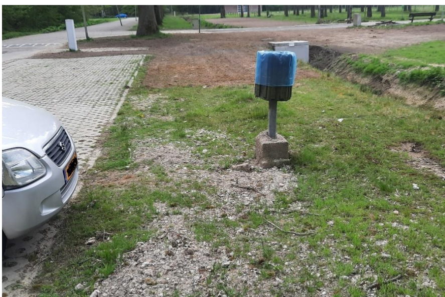
Afbeelding 9. In het voorjaar van 2022 zijn er nieuwe parkeervakken aangelegd waardoor het oppervlak van de groenstrook is afgenomen. Tevens is zichtbaar dat er puin op de vegetatie is gedeponeerd en dat er graafwerkzaamheden hebben plaatsgevonden.
