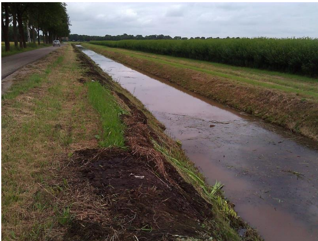
Afbeelding 1. Volledig geschoonde watergang in het groeiseizoen (Foto: Paul Hendriks)
