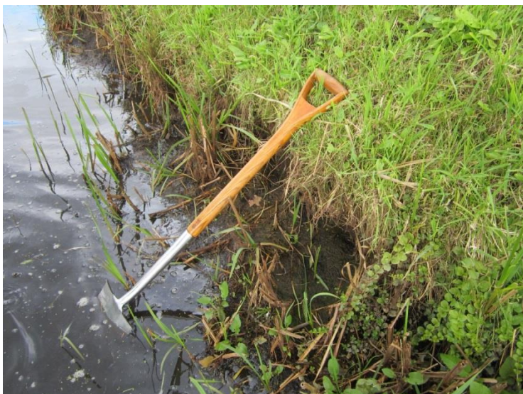
Afbeelding 12. Talud met uitgeholde onderinsteek in proeftraject Eexterveen (Foto: Melchior Leutscher)
