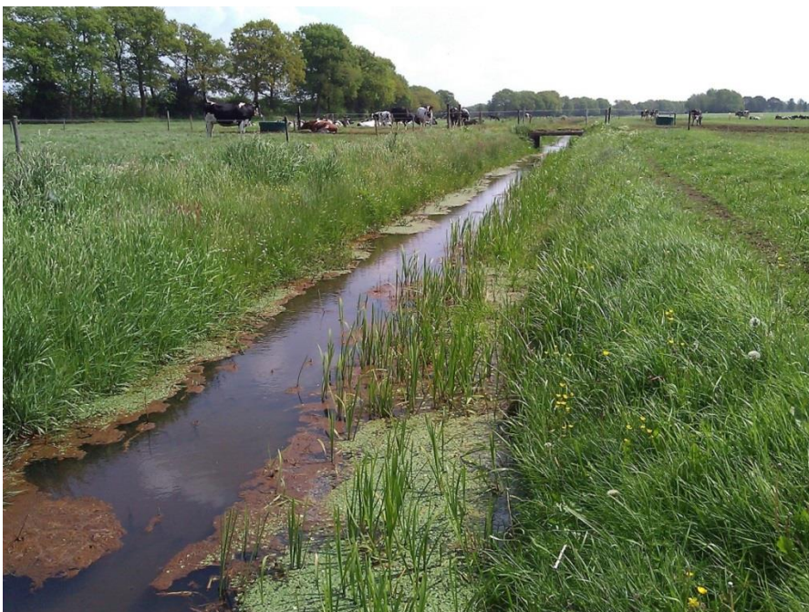
Afbeelding 5: Geul in natte profiel watergang, proeftraject Grolloo (Foto: Paul Hendriks)
