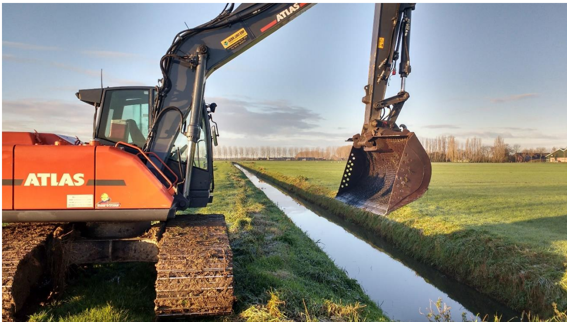
Figuur 3. De vaste bak is de meest gebruikte methode om te baggeren. Soms wordt gebruik gemaakt van geperforeerde bakken. Hierdoor loopt het water direct uit de bak en kan de aannemer een hogere werksnelheid halen; de bagger wordt in één beweging ‘met vissen’ op de kant gezet. Bij gebruik van niet-geperforeerde bakken wordt de bak na het opscheppen boven de sloot lichtelijk gekanteld, waardoor het meeste water uit de bak stroomt en vissen een kans krijgen terug te komen in de sloot
