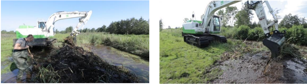
Figuur 31. Baggerwerkzaamheden op het traject Langstraat. Links: alle bagger wordt op een hoop gegooid. Rechts: alle bagger wordt dun uitgespreid.
