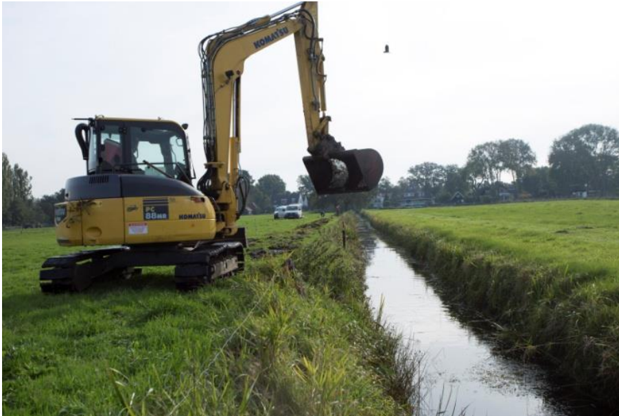
Figuur 20. Baggerwerkzaamheden op het traject Loosdrecht (4).
