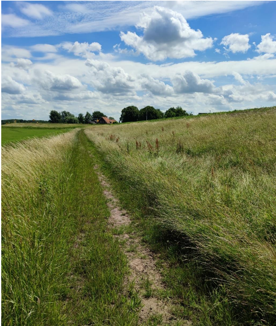
Figuur 7: Op het pad onderaan het dijktafud op monitoringslocatie 4 kunnen in potentie wilde bijen nestelen (open grond).
