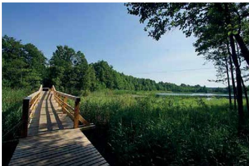
Houten brug in Varnikai.
