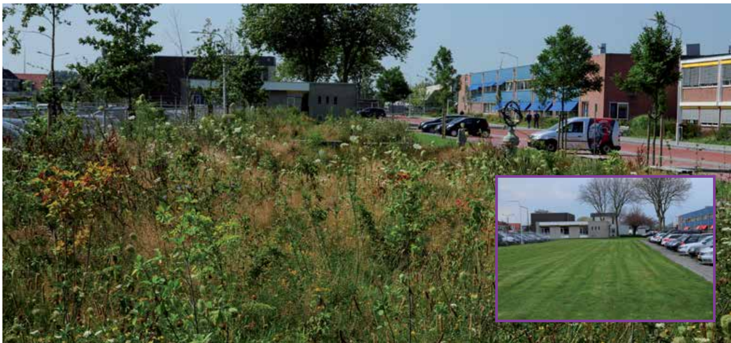
Op dit terrein is een wadi aangelegd, die wateroverlast moet verminderen en biodiversiteit oplevert. Het parkeerterrein is hierdoor ook gemaskeerd.
