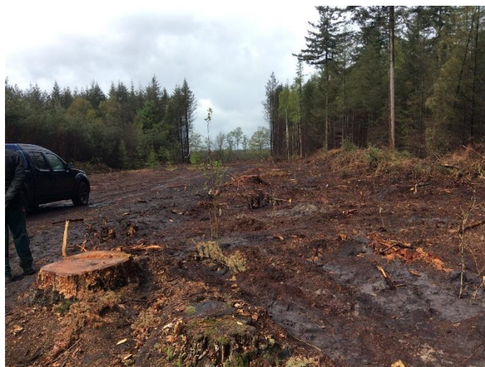
De vlindercorridor die de open natuur van België en Landgoed De Utrecht met elkaar verbindt, vlak na de aanleg.
