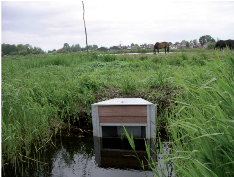
Figuur 3.1. Goed peilbeheer is belangrijk voor de kwaliteit van laagveenmoerassen. Op de foto een stuw ter regulatie van slootpeil in vlieggebied van de grote vuurvlinder.
