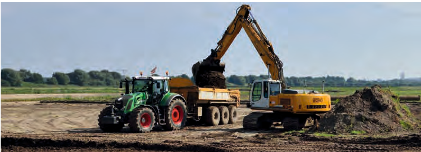
Afgraven van voedselrijke grond. Excavating nutrient-rich soil.
